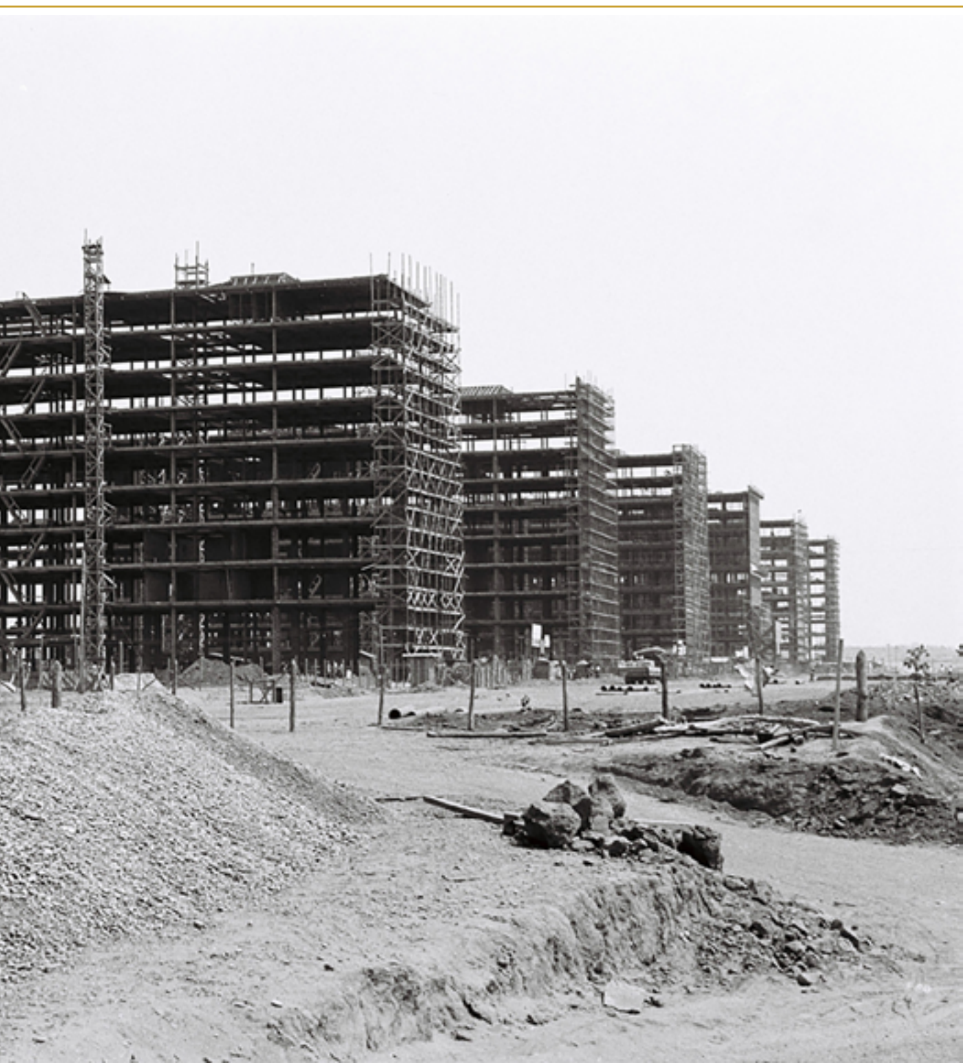
Construção de Brasília (prédios dos ministérios), 1959
