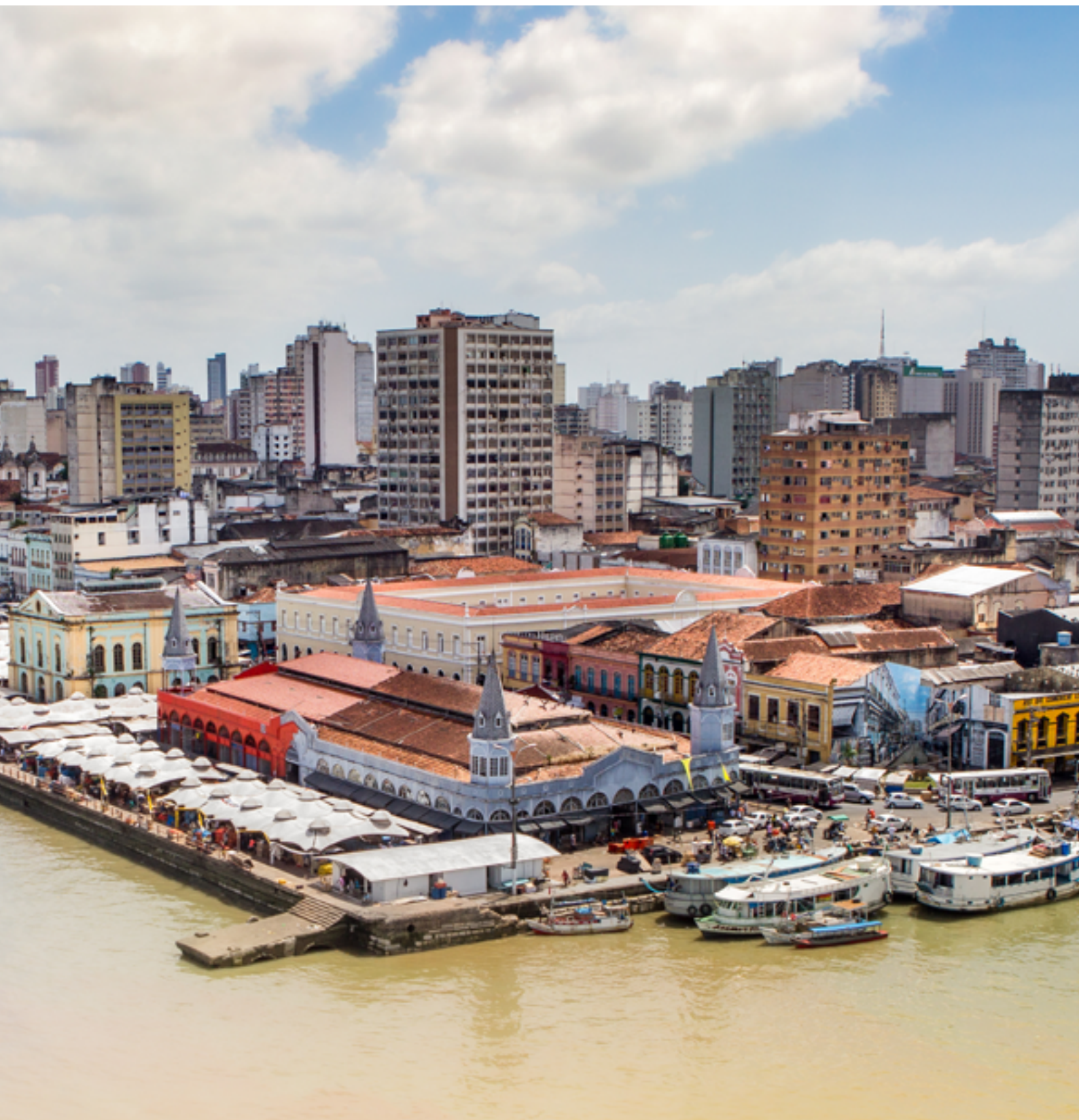
Edifícios no horizonte de Belém e Mercado Ver-o-Peso
